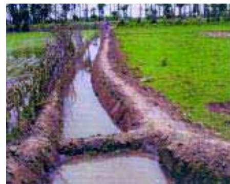
Réhabilitation des canaux de distribution d'eau.
